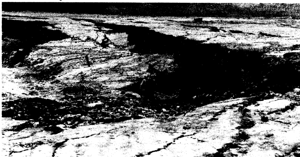
Fig. # 6.1 Agrietamiento de la capa de arcilla debido a la desecación en el vertedero.
