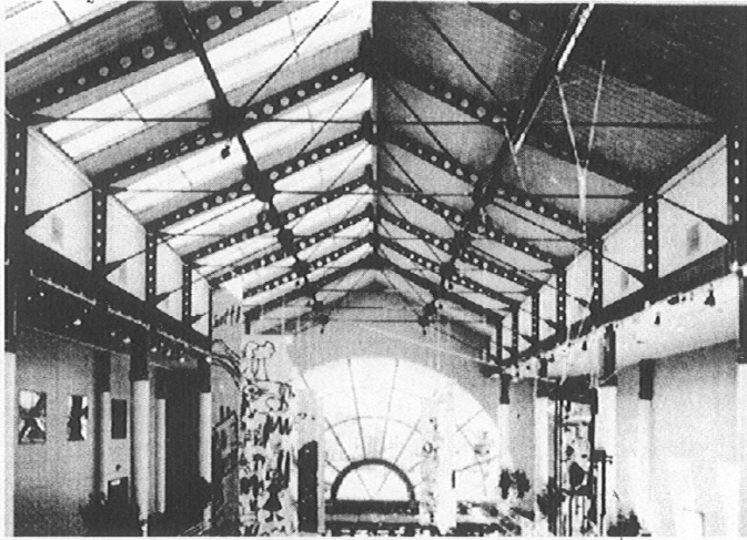
Fig. 2.4 Uso de perfiles agujerados para fines arquitectónicos en estructura principal de la cubierta.
