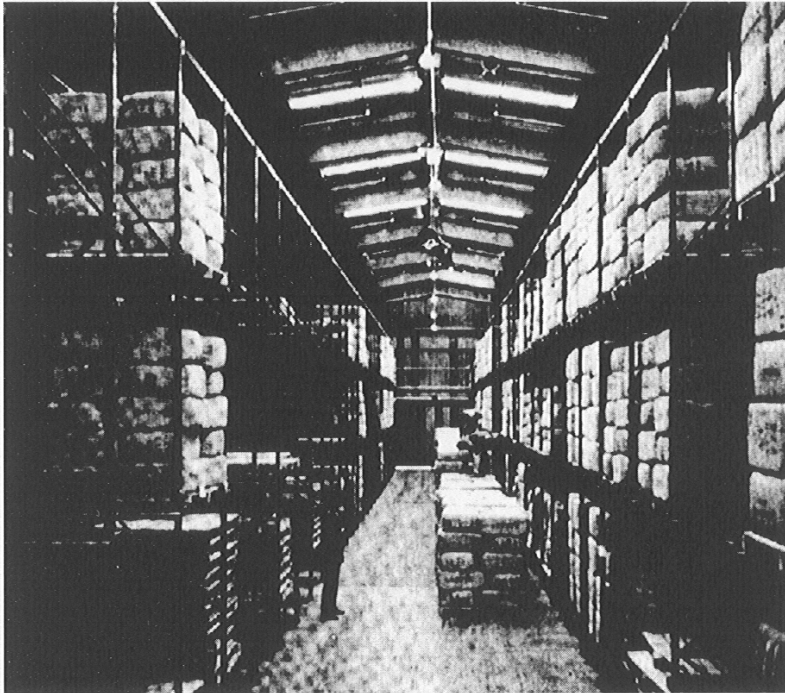
Fig. 2.5 Estantería industrial o "racks" formados con perfiles laminados en frío.
