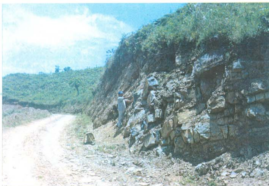
Fotografía No. 29 B
