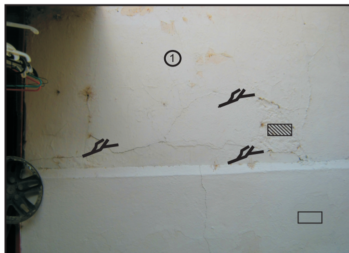
FOTOGRAFÍA 4.- MURO AL ESTE DE LA RECÁMARA POSTERIOR.
