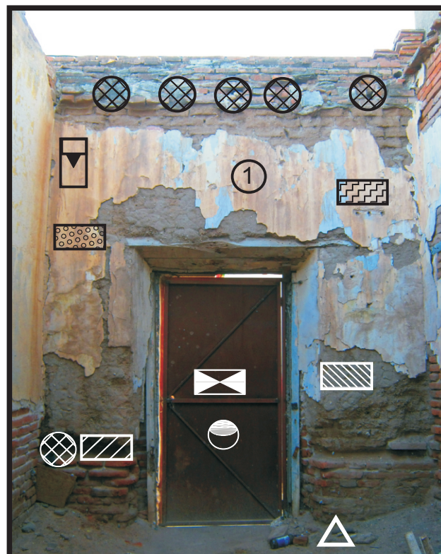
FOTO 4.- MURO AL SUR. ACCESO AL INMUEBLE.
