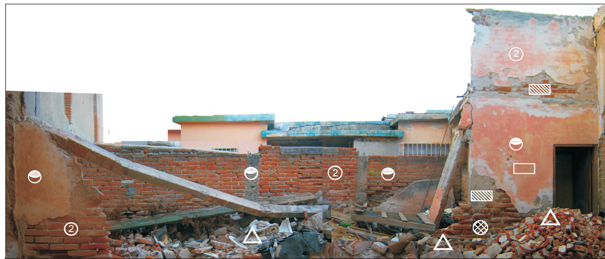
FOTOGRAFÍA 1.- MURO AL NORTE DEL PÓRTICO Y DE LA RECÁMARA.
