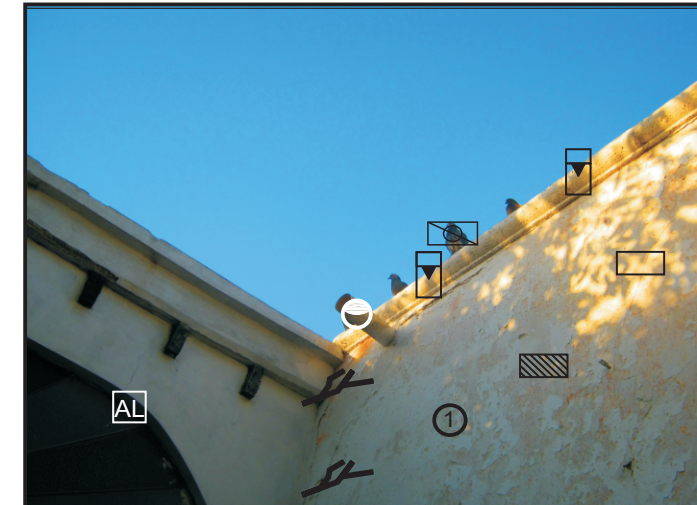
FOTOGRAFÍA 3.- VISTA SUPERIOR DEL MURO EXTERIOR EN PATIO.
