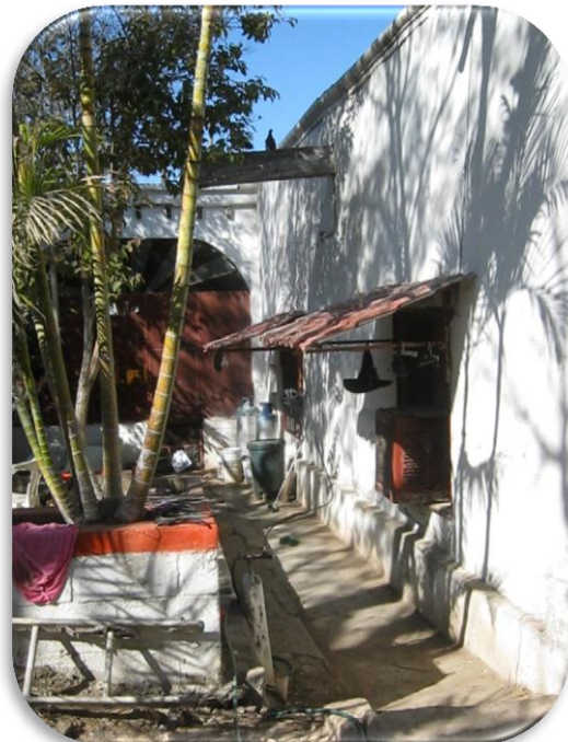
Fotografía 4. Vista del corredor exterior hacia el pórtico. Fuente: ©Aguilar/ Cuevas (2012)
