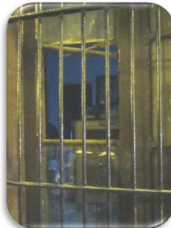
Fotografía 4.3 Ventana en la Fachada Principal. Fuente: ©Aguilar/ Cuevas (2012)
