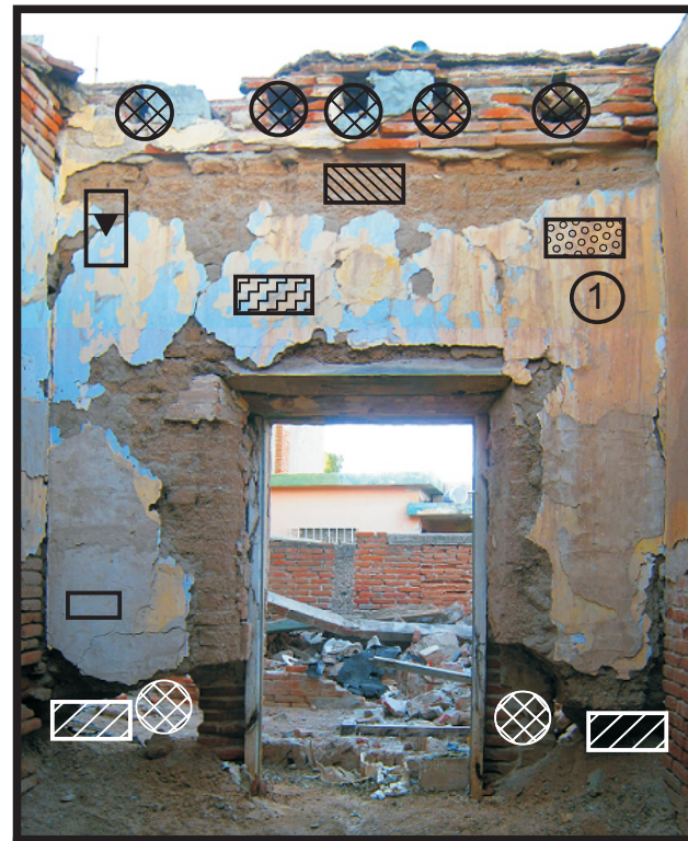
FOTO 2.- MURO AL NORTE. ACCESO AL PÓRTICO.
