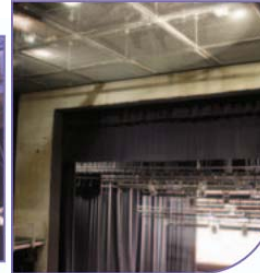
Je cable tensado
