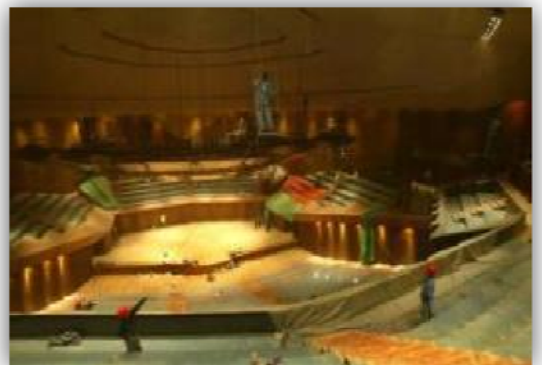
Fig. 1.41 Trabajos de remodelación en 2010. Fuente: blogspot.com.
