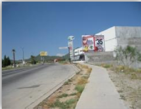
Fig 1.26 Pavimentación del terreno. Archivo propio.
