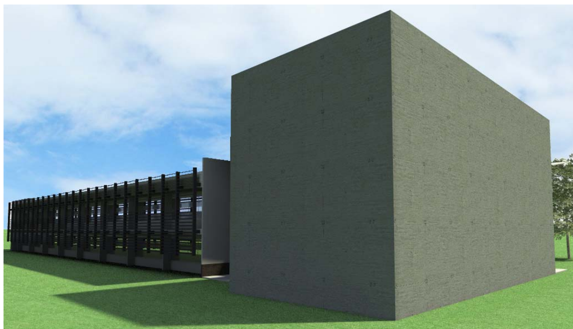
Imagen 3.9: Fachada sur del edificio de la División de Ciencias Biológicas y de la Salud/1era etapa Fuente: Archivo propio
