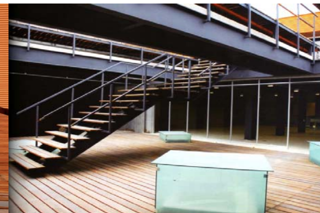
Imagen 1.63: Vistas de la parte inferior del andador
