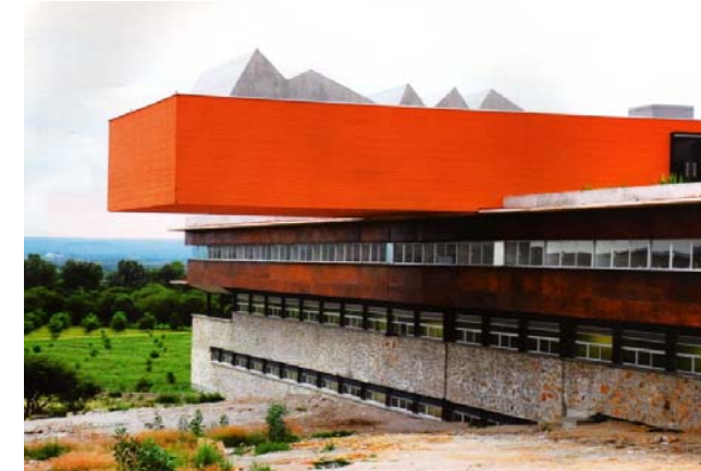
Imagen 1.59: Vista del volado del edificio
