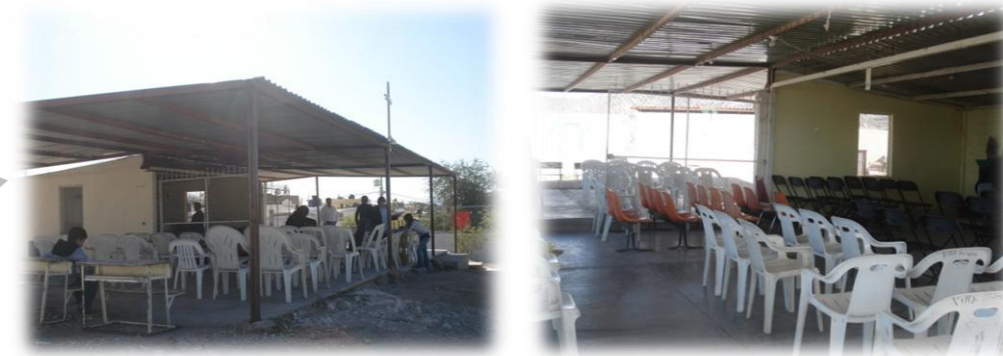
Imagen 1.9. Tejaban. A la izquierda, vista a construcción 1; a la derecha, vista al interior. (Fuente propia)
