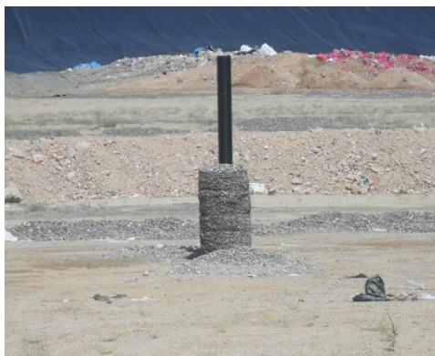
Imagen 16. A) Chimenea en fase de inicio B) Chimenea en fase terminada (Archuleta, fotografías; Relleno Sanitario, 2009).
