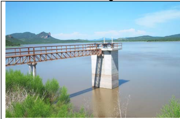
Figura 12.- Obra de toma de la Presa Punta de Agua
