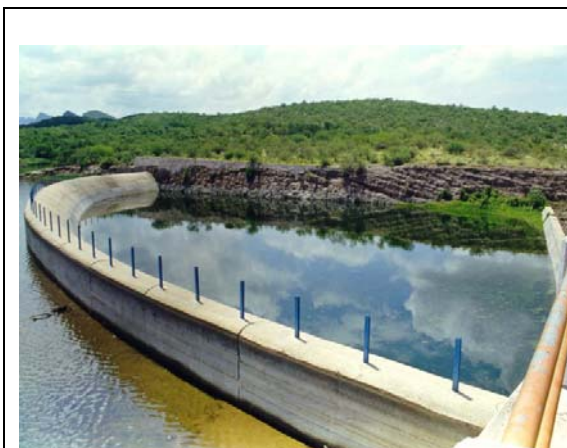
Figura 14.- Vertedor de la presa
