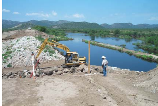
Figuras 19 a y b.- Trabajos de reparación del bordo
