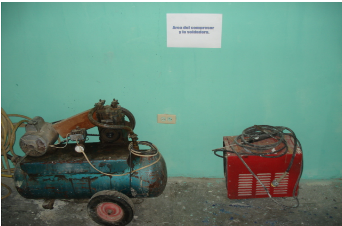
Foto 11, se despejo compresor y soldadora.
