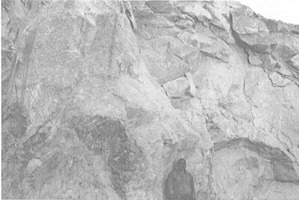
Imagen 9.1.- Roca homogénea de yeso del banco 530. El fracturamiento en la imagen es debido a los efectos de la voladura.
