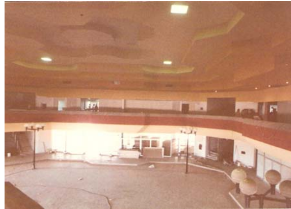
Interior Casa de la Cultura antes de su inauguración (1980)
