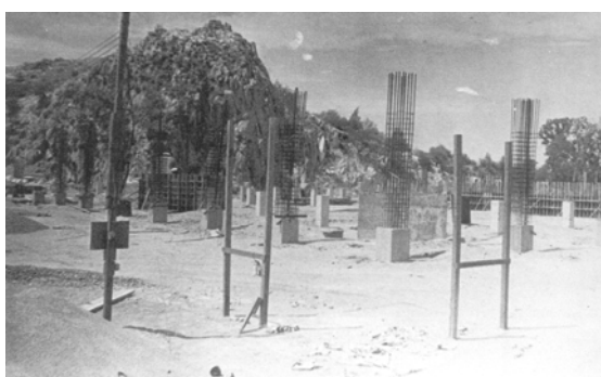
Construcción de la Casa de la Cultura, 1980 (Colección Juan Ramón Gutiérrez).
