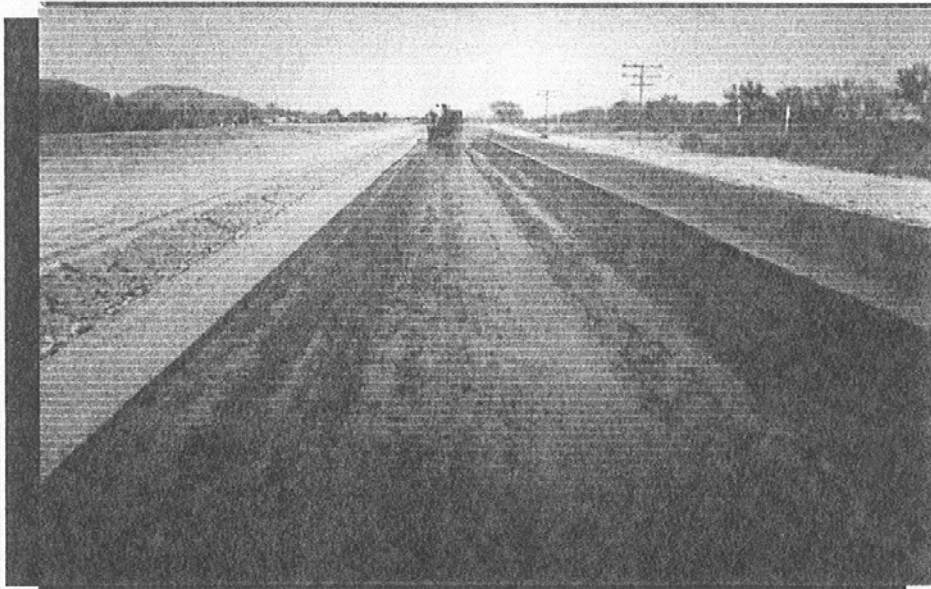
Foto No. 7.1.6 Riego de Asfalto para adherir la Carpeta Asfáltica
