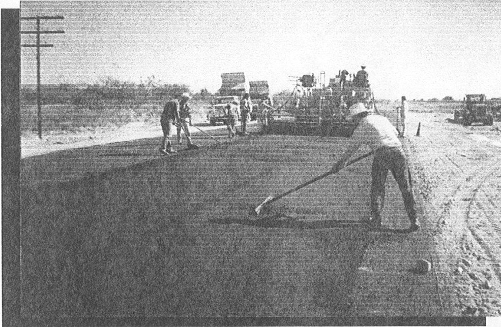
Foto No. 7.1.7 (a) Tendido de Carpeta
