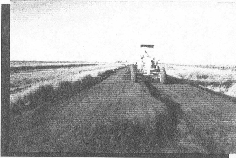
Foto No. 7.1.1 Motoconformadora mezclando el material pétreo con el producto asfáltico
