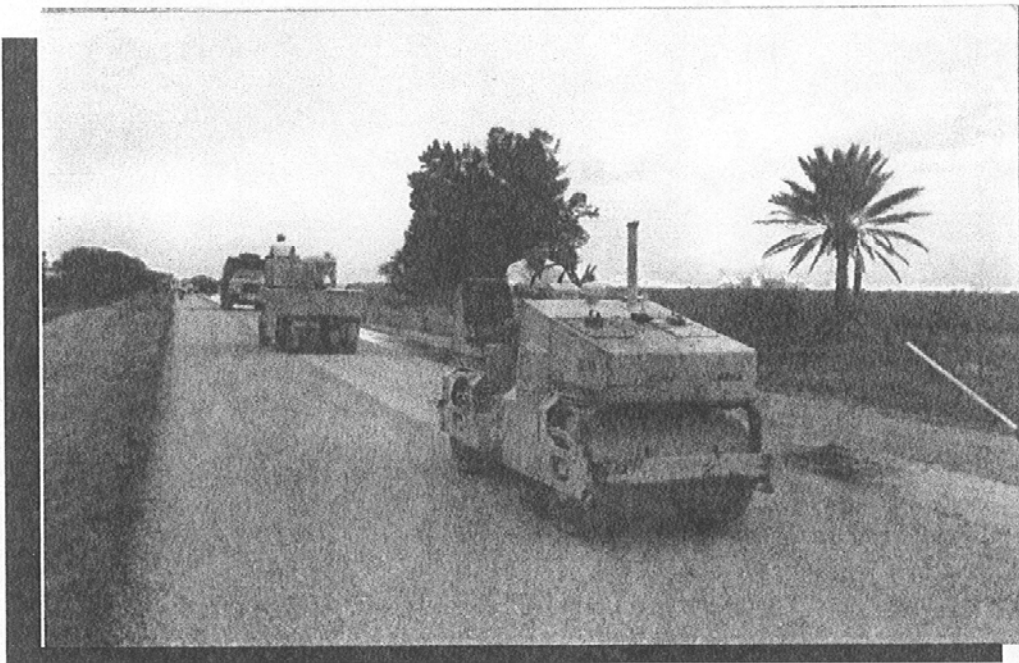
Foto 4.4 Compactación con Rodillo Liso y Neumático.
