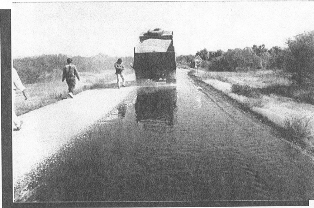
Foto 4.3 Riego del Material Pétreo.
