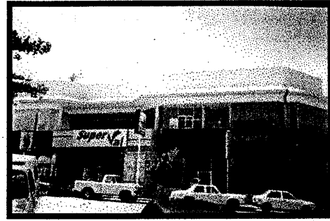
Locales comerciales y bancarios ubicados en la avenida Juárez y sexta este.
