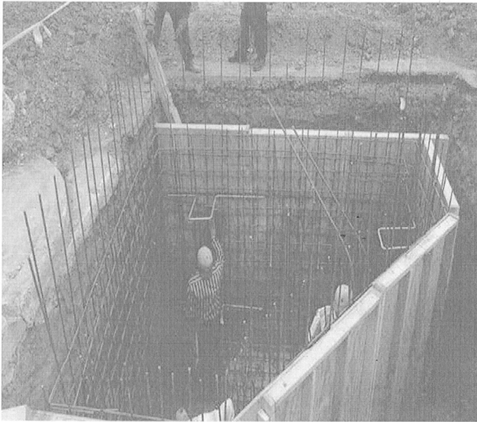
Foto 6.2 Construcción de Registros de deflexión
