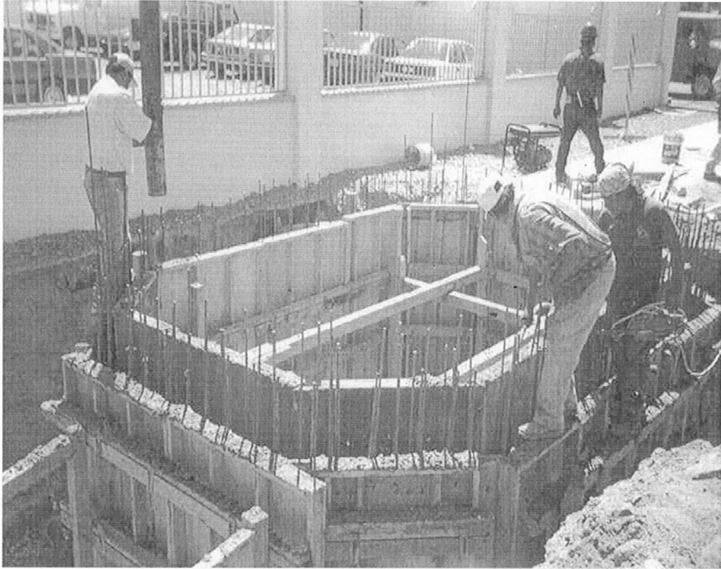
Foto 6.1 Construcción de Registros de Empalme
