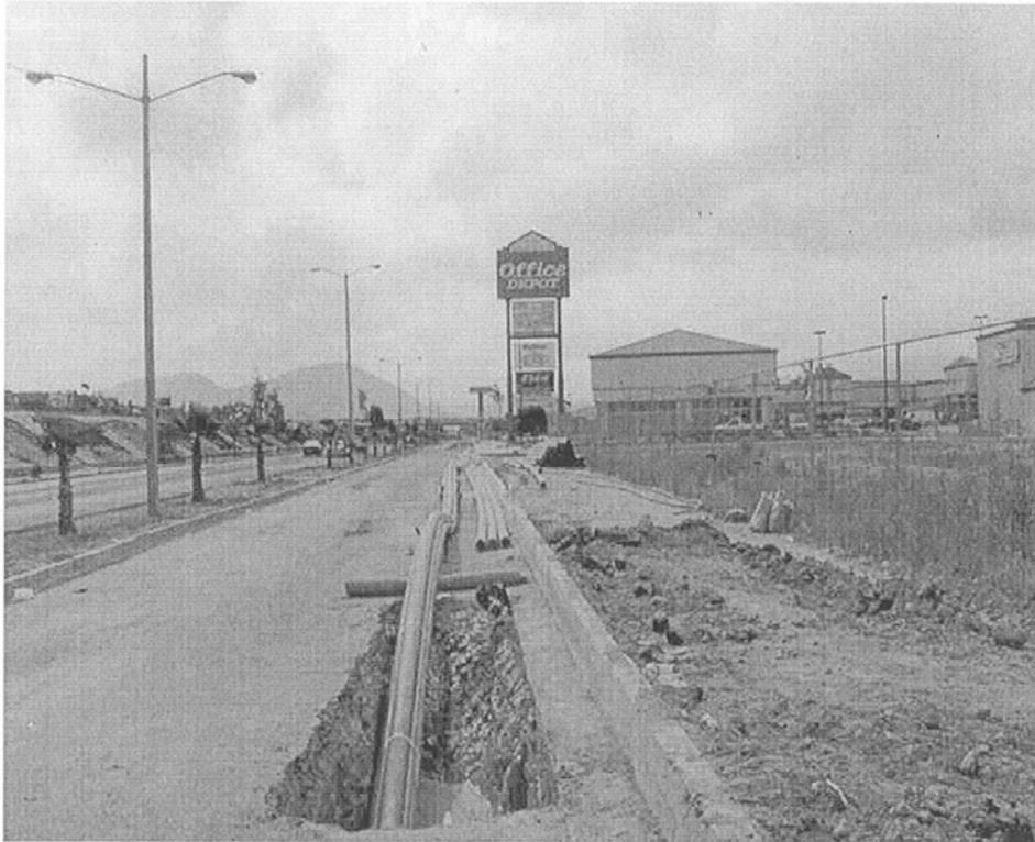
Foto 5.10 Introducción del AS de ductos
