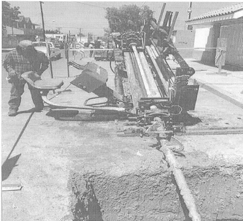
**Foto 5.3** Inclinación de entrada de la barrena
