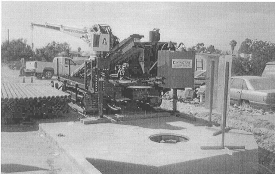
Foto 5.1 Máquina de barrenación direccional, tipo contractor 6510
