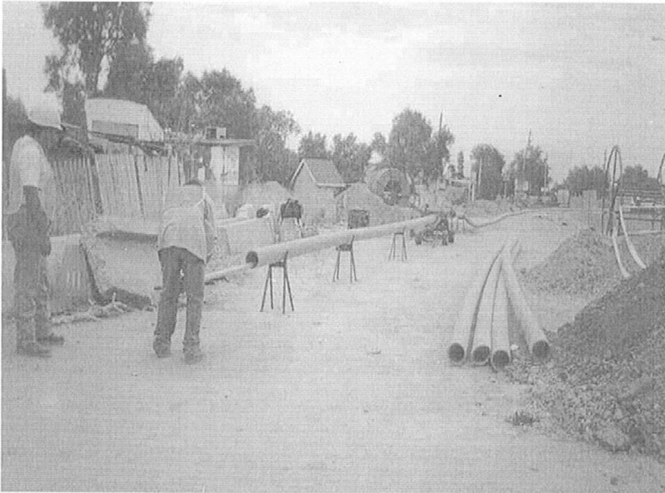
Foto 5.8 Unión de tubería de polietileno de 6" de diámetro unidos por Termofusión
