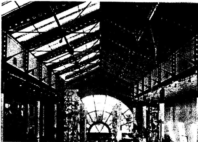
Fig.2.2 Uso de perfiles agujerados como estructura Principal de la cubierta.
